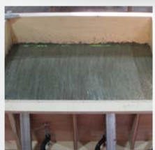
3.광섬유/ 콘크리트 적층
